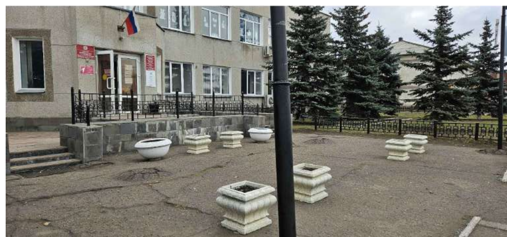
Вид на крыльцо здания по ул. Октябрьская, 91
